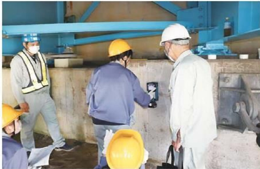
鉄筋探査機を使って点検する学生＝21日、かほく市内
